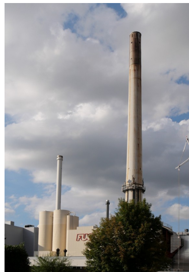
FUG Heizkraftwerk Weststadt
